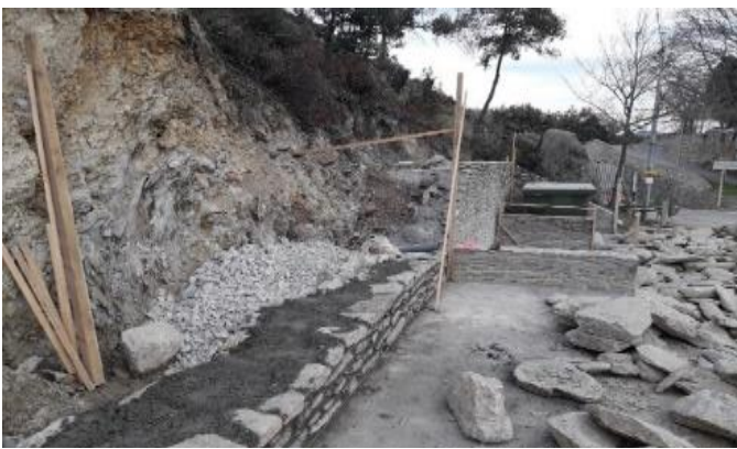
Le site au moment des travaux en février 2024
