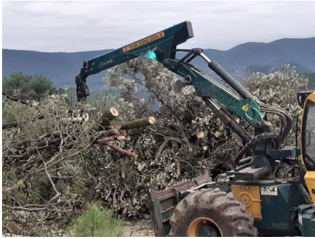
Les travaux de déboisement
