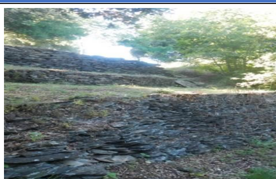
BANCELS en terrain schisteux à Arbousse
