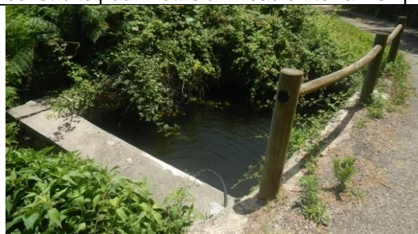
BASSIN entretenu à Soustelle (l'église)
