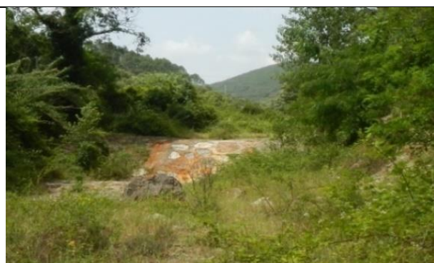
SEUIL construit pour ralentir le courant de la Grave
