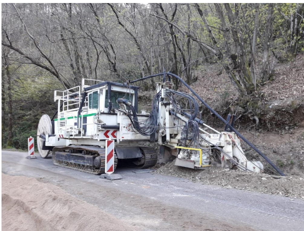
Fin 2021 les travaux sont maintenant terminés
